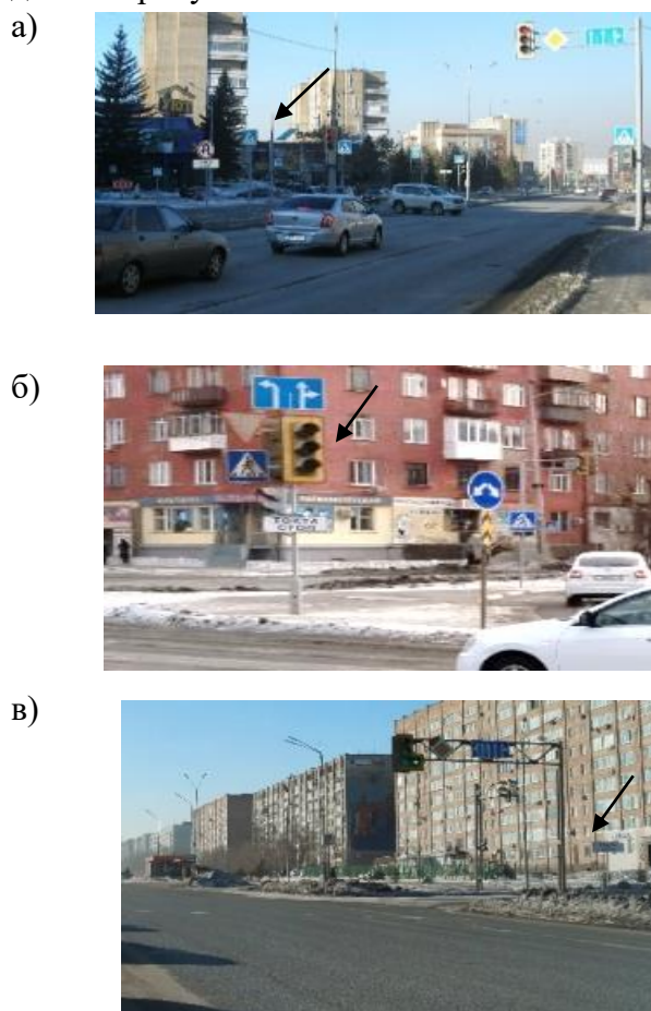
Рисунок 1. Примеры установки знаков 5.33 «Стоп-линия», которые не соответствуют требованиям стандарта, а- установка знака 5.33 «Стоп-линия» слева от проезжей части дороги без дублирования над проезжей частью при многополосном движении; б- установка знака 5.33 «Стоп-линия» на опоре светофора; в - установка знака 5.33 «Стоп-линия» справа от проезжей части без дублирования над проезжей частью при многополосном движении.
